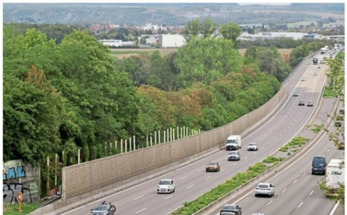
Anstelle der maroden Lärmschutzwand wurde entlang der Autobahn 81 in Freiberg ein Provisorium errichtet.
